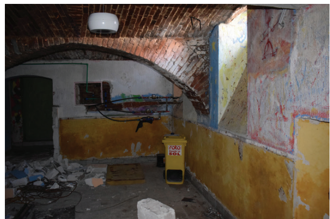
Pripravljala dela za obnovo v polnem teku
